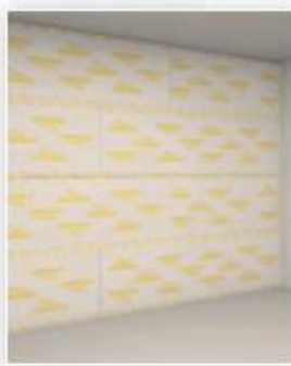
2. Οριζόντια τοποθέτηση γυψοσανίδων
