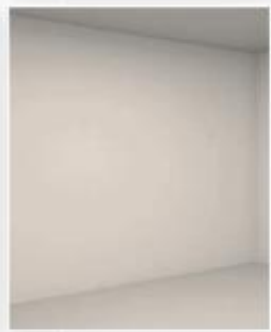
9. Ολοκλήρωση αρμολόγησης επιφάνειας
