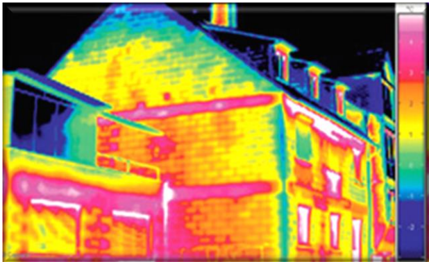
Σπίτι χωρίς εξωτερική θερμομόνωση
